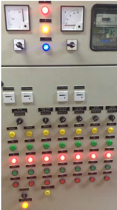
ภาพที่ 7 ภาพแสดงตู้ควบคุมไฟฟ้าภายนอก-ภายใน ของระบบปั๊มต่างๆ ระบบบำบัดน้ำเสีย
