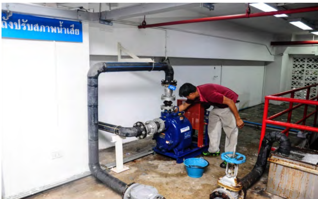
ภาพที่ 10 ภาพแสดงการบำรุงรักษาเครื่องสูบน้ำเสีย SP1, SP2
