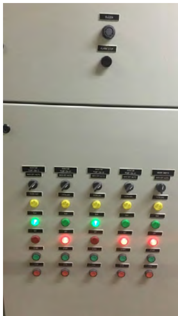
ภาพที่ 8 ภาพแสดงตู้ควบคุมไฟฟ้าภายนอก-ภายใน ของระบบปั๊มเติมอากาศระบบบำบัดน้ำเสีย
