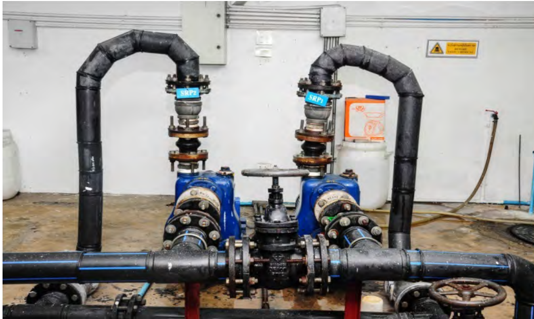
ภาพที่ 11 ภาพแสดงการบำรุงรักษาเครื่องสูบน้ำตะกอนเวียนกลับ SRP1, SRP2
