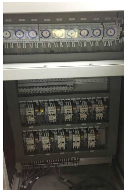
ภาพที่ 8 ภาพแสดงตู้ควบคุมไฟฟ้าภายนอก-ภายใน ของระบบปั๊มเติมอากาศระบบบำบัดน้ำเสีย
