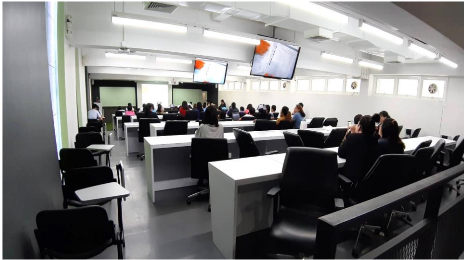
ภาพที่ 3 งานปรับปรุงสิ่งก่อสร้างเพื่อสนับสนุนพันธกิจด้านการศึกษา (การติดตั้งครุภัณฑ์และวัสดุอุปกรณ์ภายในห้องเรียน มหิดล-BSTM)
